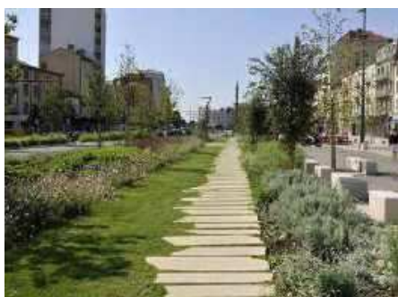
Aménagement des boulevards du Centre de Valence Gautier - Conquet Architecture
