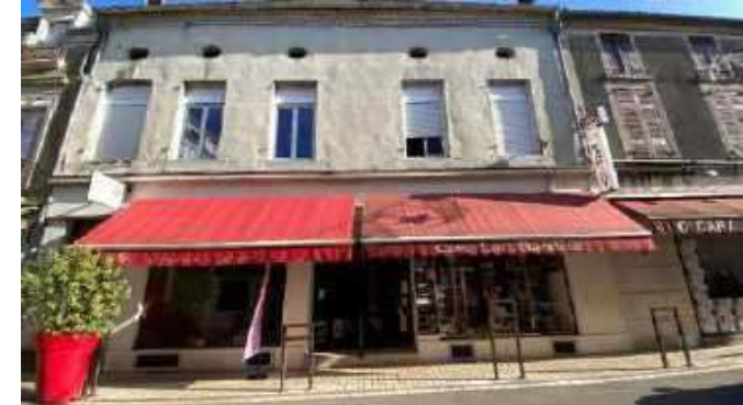
Immeubles rue Gambette parcelles 19 et 22
