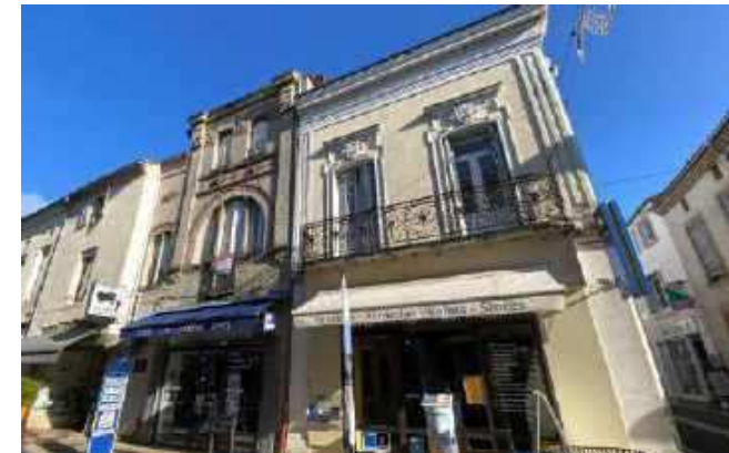
Immeubles rue Gambette parcelle 25 et 26
